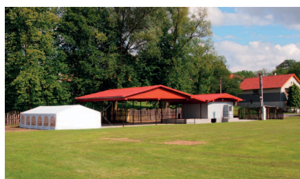
Rekonstruované vyletiště v Kunčicích
