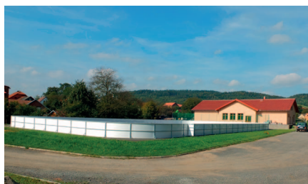
Víceúčelové hřiště ve Strážné n.L.
