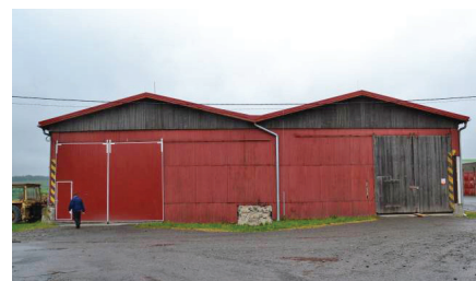
Zrekonstruovaná hala v ZD Partutovice
