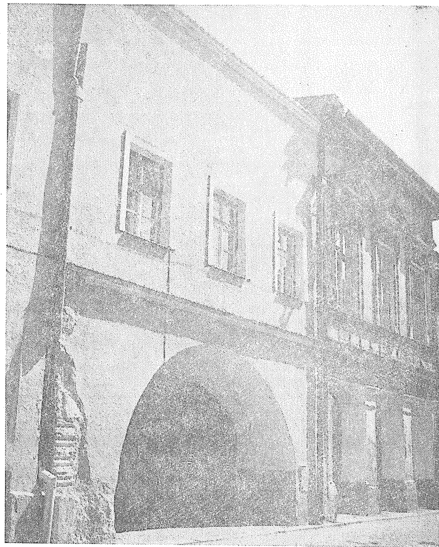
Průčelí domu čp. 102 Městské knihovny na Horním podloubí po renovaci.
