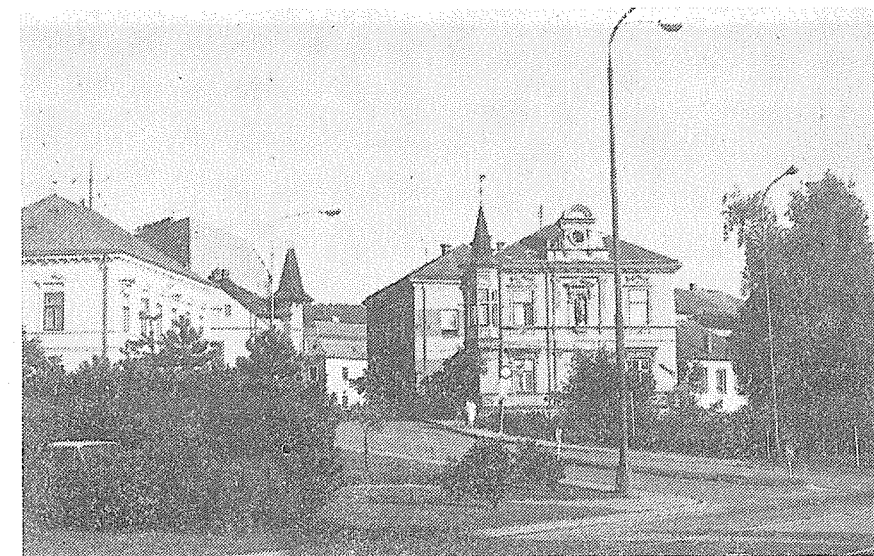
Po výstavbě křižovatky.
