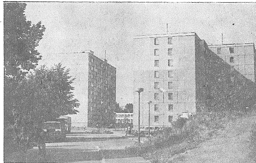
Galašova ulice — po výstavbě.
