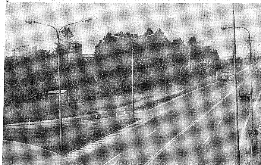
Silniční průtah v bývalé ul. P. Lumumby.
