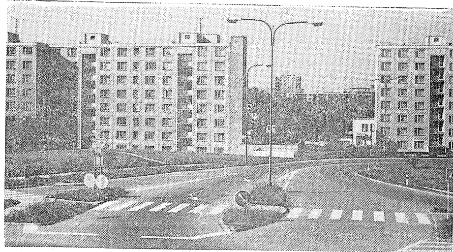
Tř. 1. máje po výstavbě.
