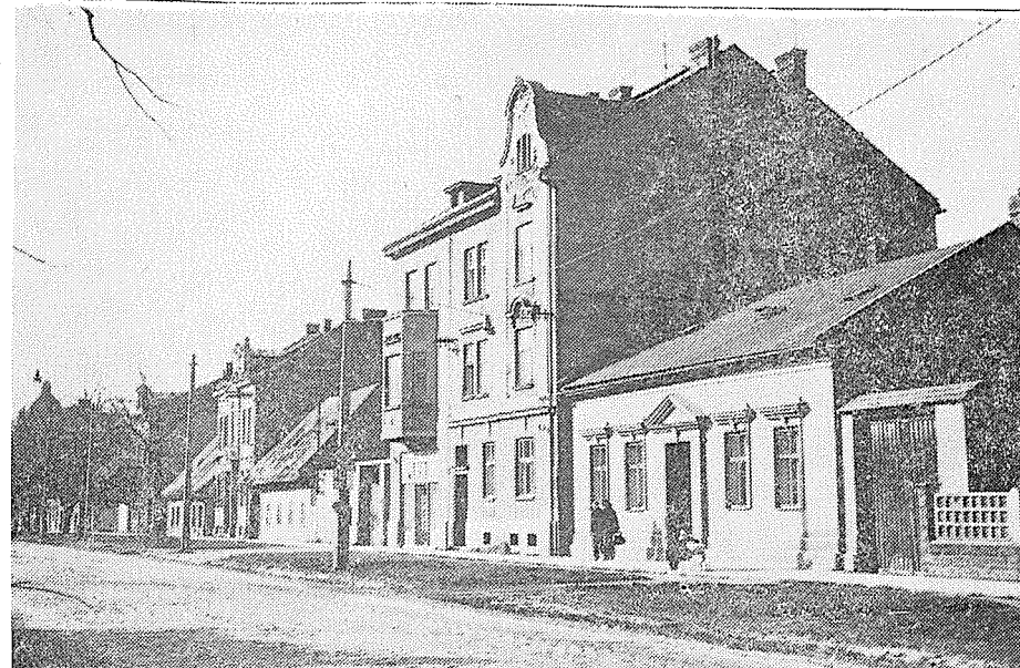
Tř. 1. máje před výstavbou (dům stavitele Vostřeze a dům pana Večeři)
