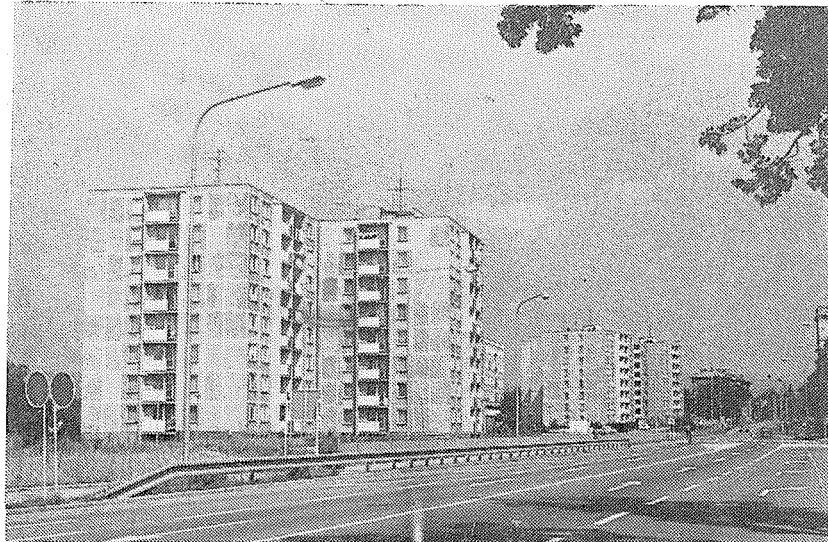
Třída 1. máje po výstavbě. Foto: Č. Novotný.
