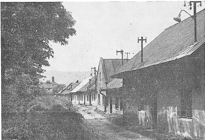
Na Hrázi před výstavbou.
