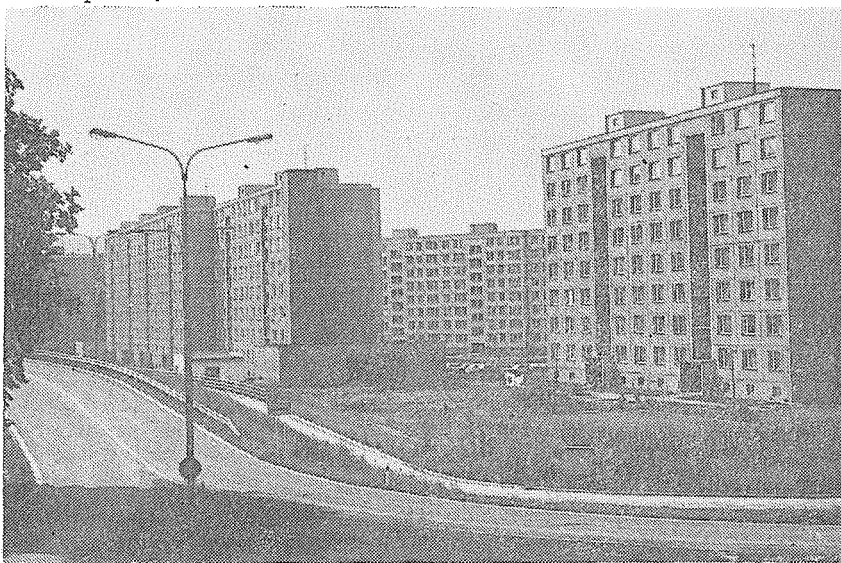
Na Hrázi po výstavbě. Fotografie: Čermír Novotný.
