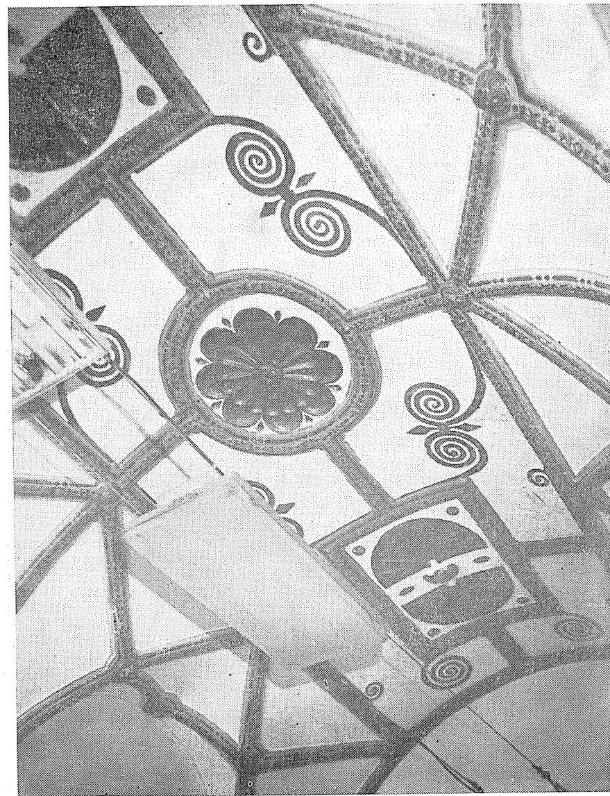
Zlacený a polychromovaný štukový strop Molova pokojíku nad průjezdní branou zámku. Foto: K. Fon 1985.
