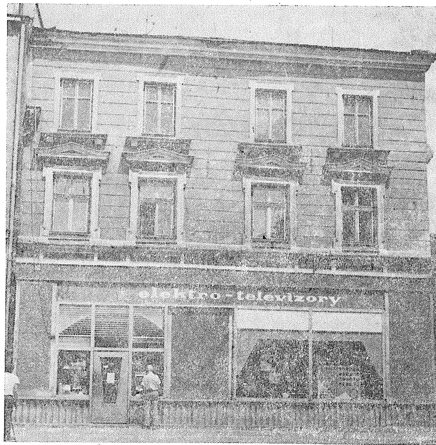
Dům čp. 119 na rohu náměstí se slepou nástavcovou zdi 2. patra. Foto: K. Fon 1983.
