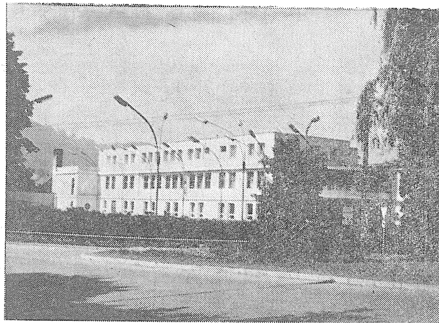
Jan Mlček: Hranická sokolovna po rekonstrukci v roce 1976
