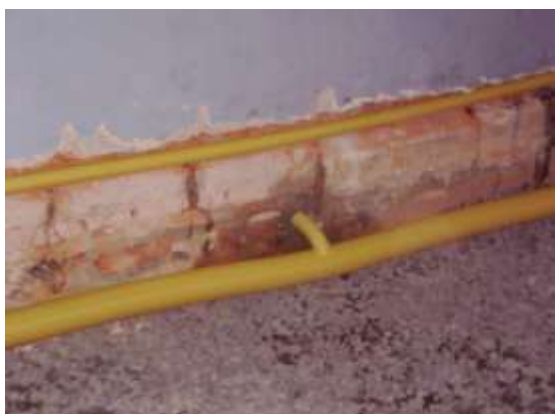
Obrázek 147 Odvětrání podlahy a stěny bylo uděláno důkladně-díry vyvrtal J.Číhal-OMO
