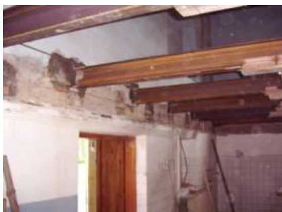
Obrázek 115 Montáž nového stropu
