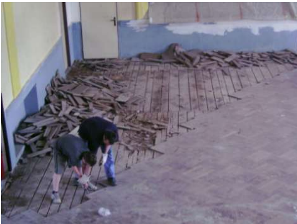
Obrázek 128 Vytrhávání parket začalo 28.6.2004 v odpoledních hodinách, M a M. Cvekovi
