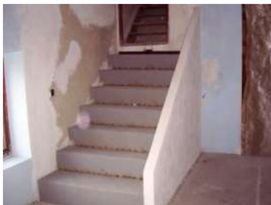
Obrázek 112 Schody na půdu před dokončením
