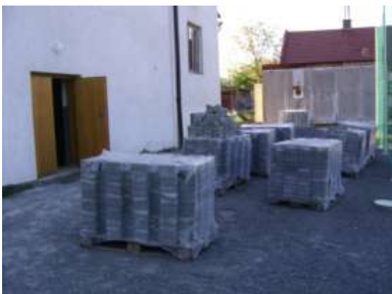
Obrázek 207 Palety s dlažbou jsou připravené na pokládku
