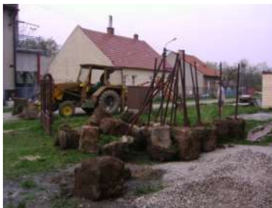
Obrázek 248 Staré sloupky jsme vytrhali pomocí stroje B. Valenty
