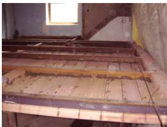
Obrázek 114 Montáž nového stropu
