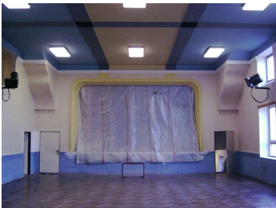
Obrázek 127 Takto vypadal sál před zahájením opravy podlahy- právě probíhají dokončovací práce na jevišti
