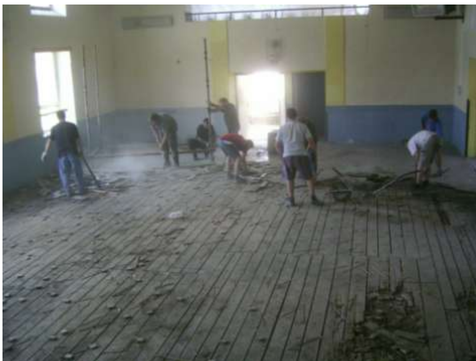
Obrázek 129 Vytrhávání parket začalo 28.6.2004 v odpoledních hodinách, M a M. Cvekovi
