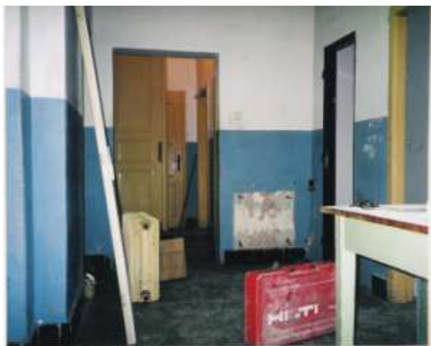
Obrázek 39 Původní WC a chodba
