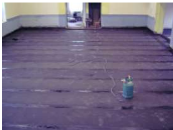
Obrázek 154 Na beton byly nalepeny dvě vrstvy lepenky
