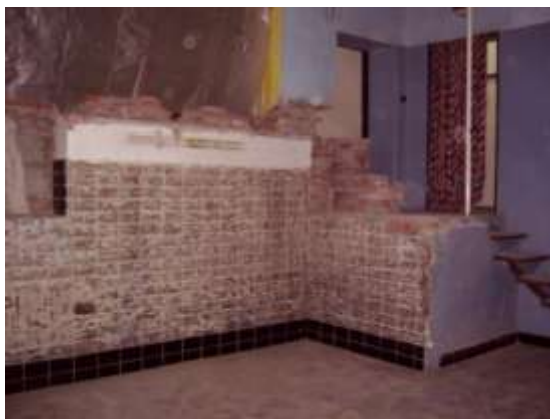
Obrázek 117 Velmi pracné bylo odstranění obkladů ze stěn bufetu
