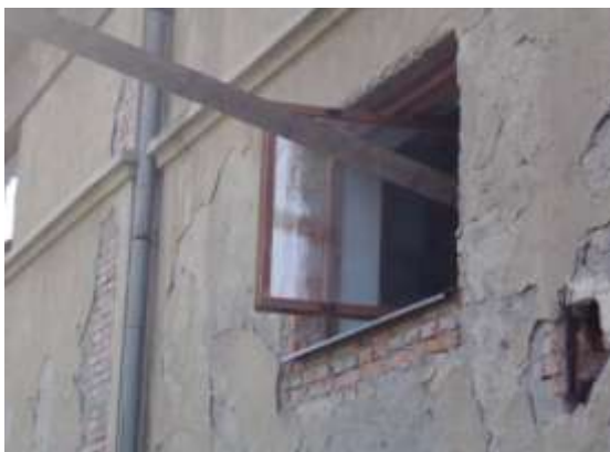
Obrázek 109 Staré trámy opouštějí sokolovnu
