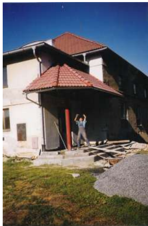
Obrázek 66 Betonování schodiště
