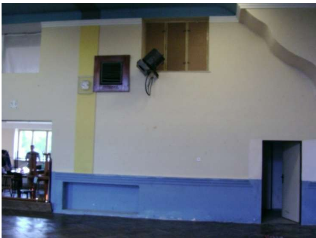
Obrázek 126 Takto vypadal sál před zahájením opravy podlahy- právě probíhají dokončovací práce na jevišti
