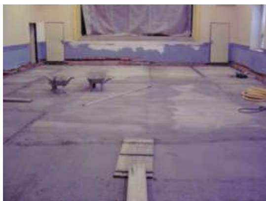
Obrázek 153 Podlaha je zabetonována
