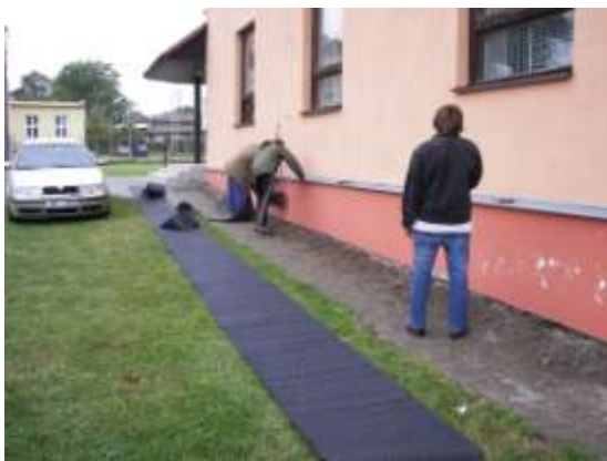
Obrázek 340 Proti vlhkosti byla vedle zdi položena bublinková folie
