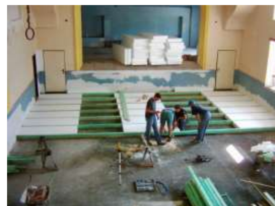
Obrázek 152 Mezi trámy se dával 10 cm vysoký polystyren
