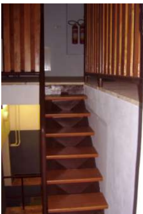
Obrázek 121 Zábradlí a všechna schodiště udělali M. Cvek a M. Krajíček
