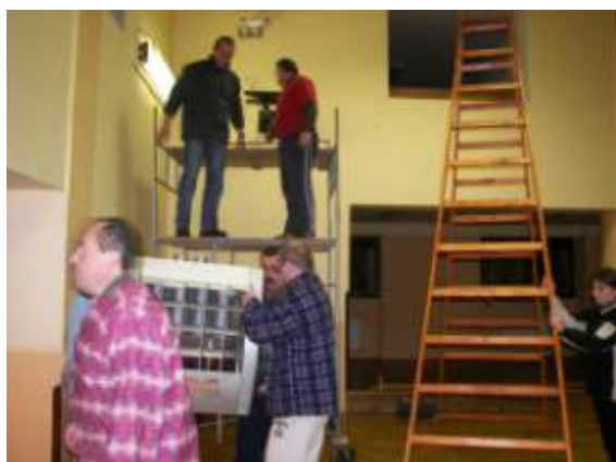
Obrázek 400 Demontáž topidla před odvozem
