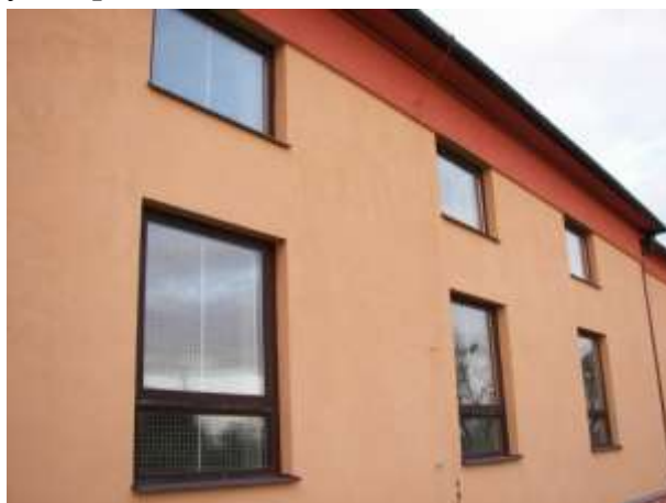
Obrázek 338 Do těchto oken byla vložena dvojskla, celkem jsou tam tři
