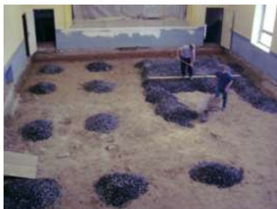
Obrázek 140 Navážka šterku na sál, bylo nutno navést cca 40 cm šterku a vyrovnat ho
