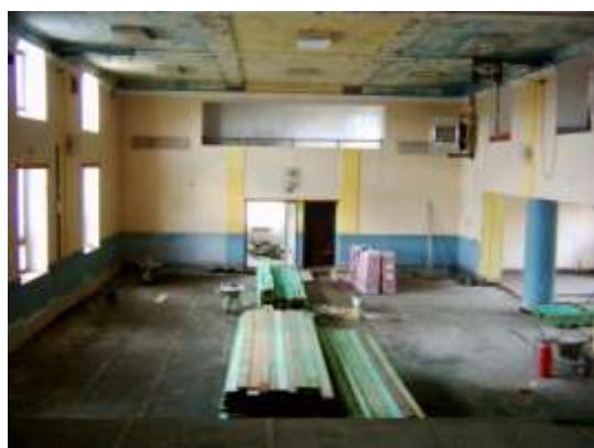
Obrázek 157 Navezeny trámy na záklop pod parkety
