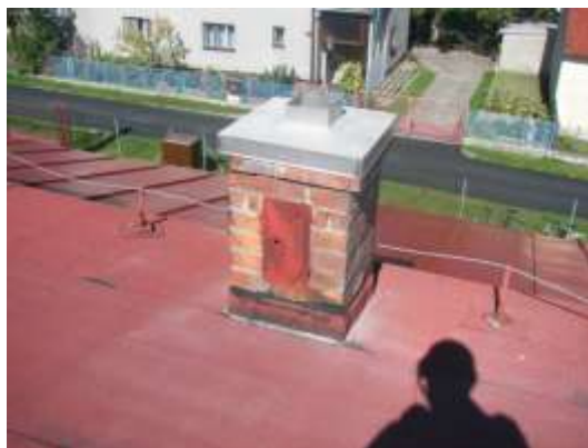
Obrázek 284 Na střechu nad jeviště byla položena nová krytina, plechová střecha byla natřena a komín oplechován.
