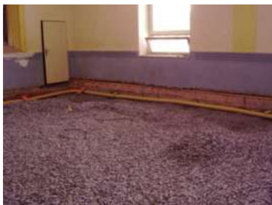
Obrázek 146 Odvětrání podlahy a stěny bylo uděláno důkladně-díry vyvrtal J. Číhal - OMO
