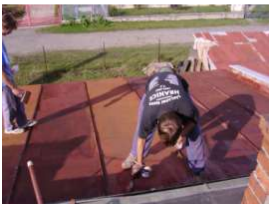
Obrázek 179 Nátěr střechy nad jevištěm
