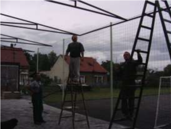
Obrázek 218 Montáž přístřešku od hřiště
