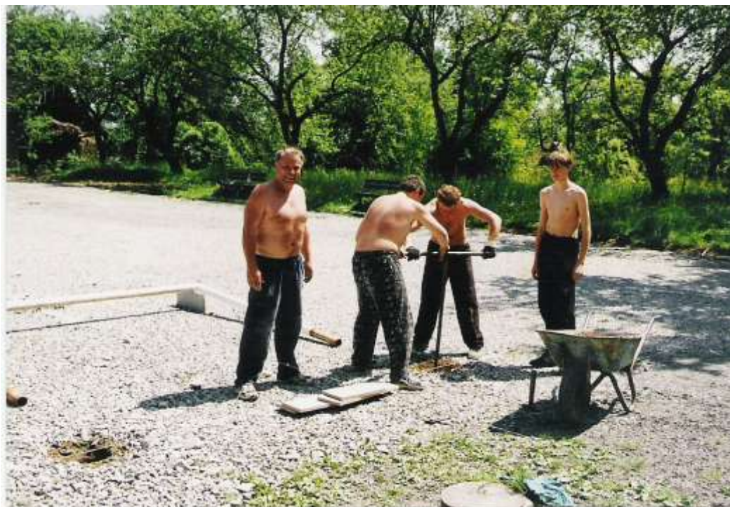
Obrázek 58 Vrtání děr pro osazení branky
