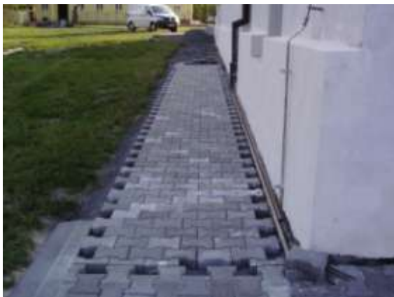
Obrázek 213 Po vydláždění za sokolovnou jsme udělal chodník podél sokolovny
