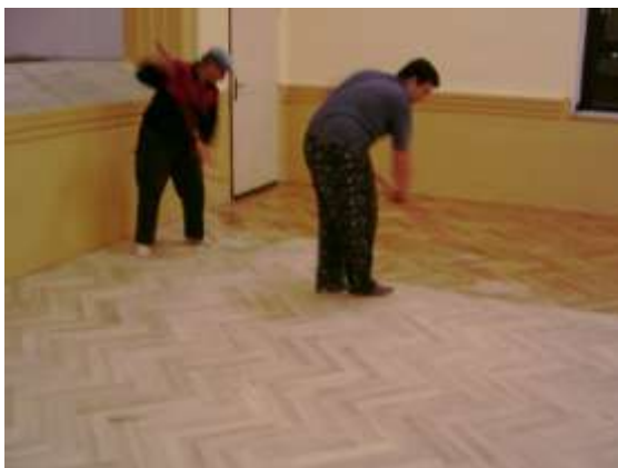
Obrázek 158 Natírání olejem, B. a M. Zlámal
