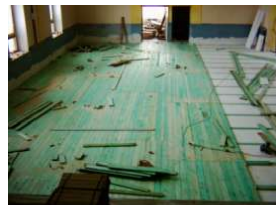
Obrázek 155 Záklop je téměř hotový, desky na záklop byly zakoupeny v roce 1996
