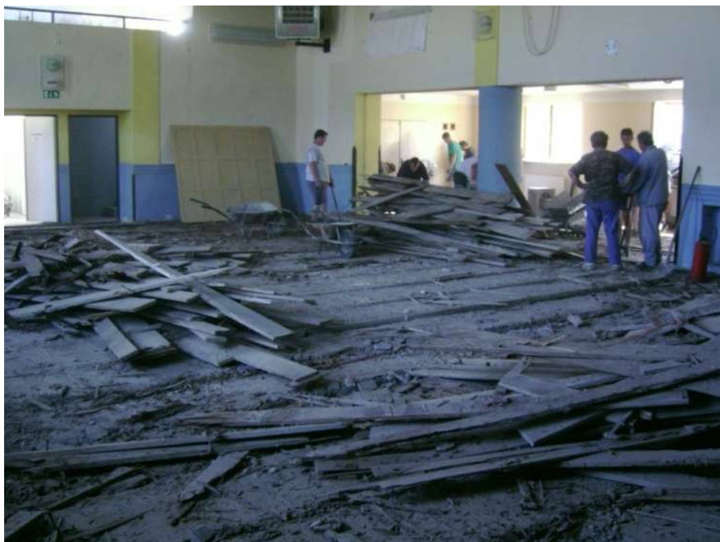
Obrázek 133 Parkety skončily na vlečce, záklop byl vyvezen na zahradu a spálen, dřevo bylo nakažené dřevomorkou
