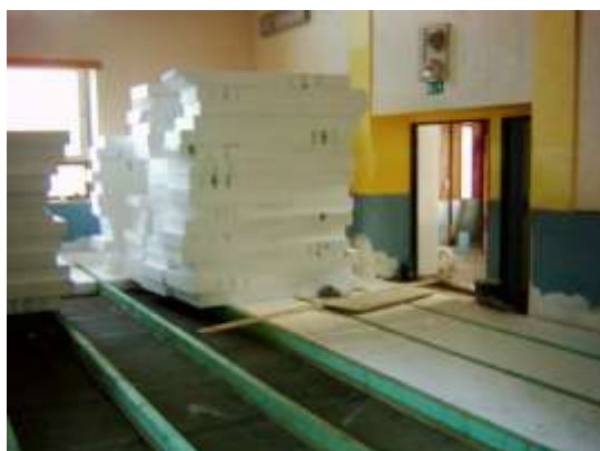
Obrázek 156 Pod trámy je pružný pásek izolace
