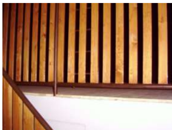
Obrázek 122 Zábradlí a všechna schodiště udělali M. Cvek a M. Krajíček
