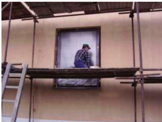
Obrázek 223 Z. Filak provedl nátěr celé sokolovny
