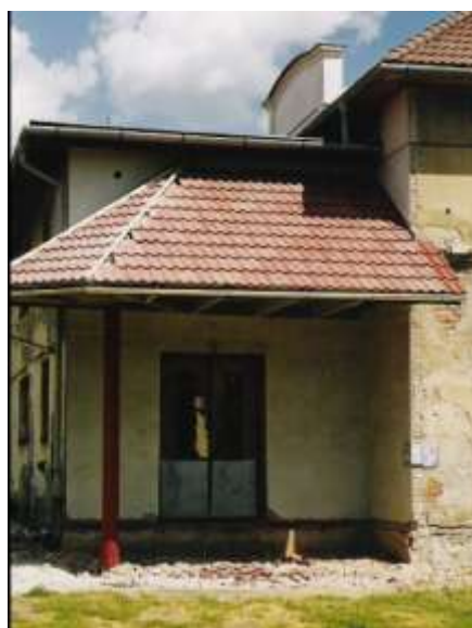
Obrázek 63 Zastřešení je takřka hotovo
