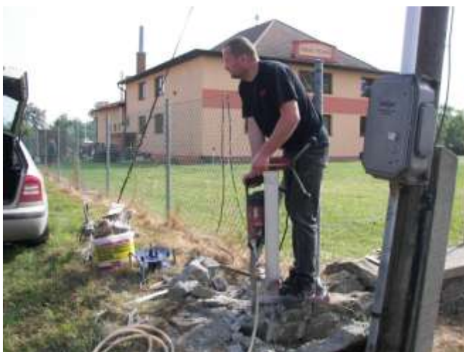
Obrázek 390 J. Číhal vrtá díru pro sloupek na plot
