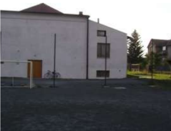
Obrázek 177 Od hřiště byly zabetonované sloupy pro ochrannou síť
