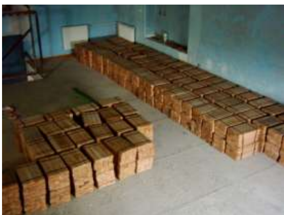
Obrázek 162 Parkety jsme donesli z půdy na jeviště, aby měly stejnou vlhkost
