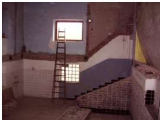
Obrázek 116 Velmi pracné bylo odstranění obkladů ze stěn bufetu
