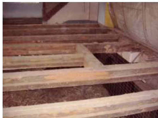
Obrázek 108 Konstrukce jeviště z trámů
