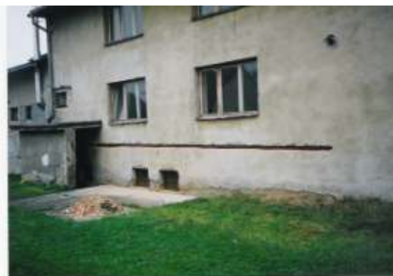
Obrázek 36 Drážka pro plynovou přípojku
