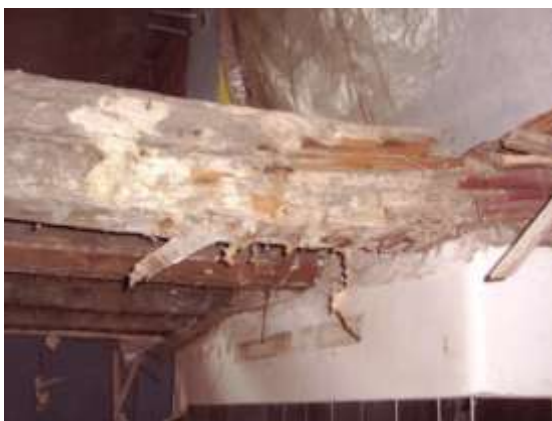
Obrázek 107 Zub času se poznamenal na trámech
