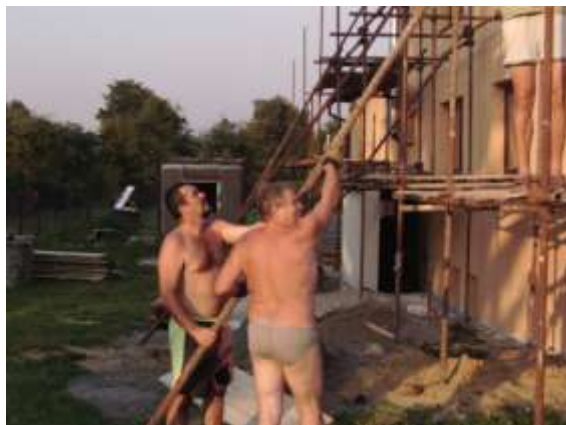
Obrázek 212 M. Krajíček a P. Zlámal při stavbě lešení
