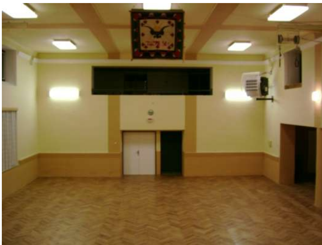
Obrázek 169 Oprava podlahy a jeviště je hotová, i vlajka z roku 1924 se tu vyjímá
