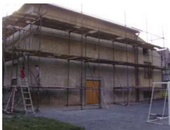
Obrázek 174 Lešení bylo postavené kolem jihozápadní stěny a od hřiště
