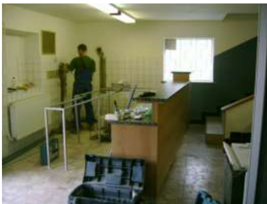
Obrázek 249 J. Kandler provádí odborné instalatérské práce
