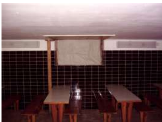
Obrázek 102 Strop bufetu podepřený trámem
