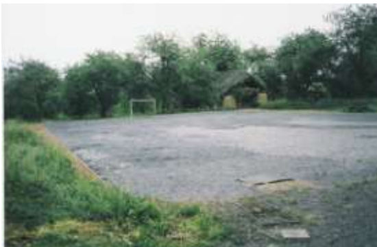
Obrázek 56 Šterk a výfrezky jsou rozhrnuty
