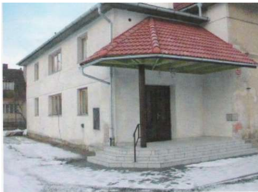
Obrázek 68 Vstup je hotový včetně nového schodiště z terasové dlažby, před schodištěm je položena zámková dlažba
