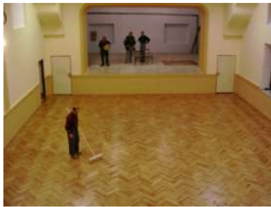
Obrázek 167 L. Zlámal dokončuje nátěr parket, na jevišti kontrolují B. a P. Zlámali a M. Cvek
