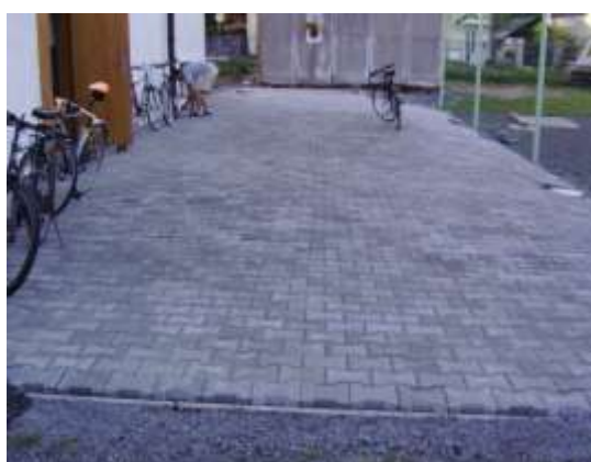
Obrázek 211 Dlažba za sokolovnou je hotová
