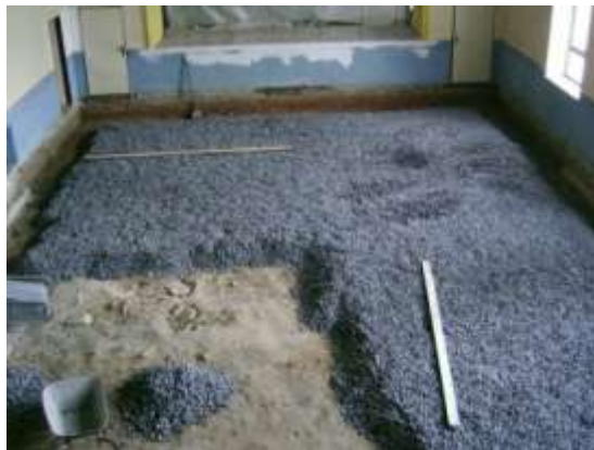
Obrázek 150 Štěrk je již skoro na sále
