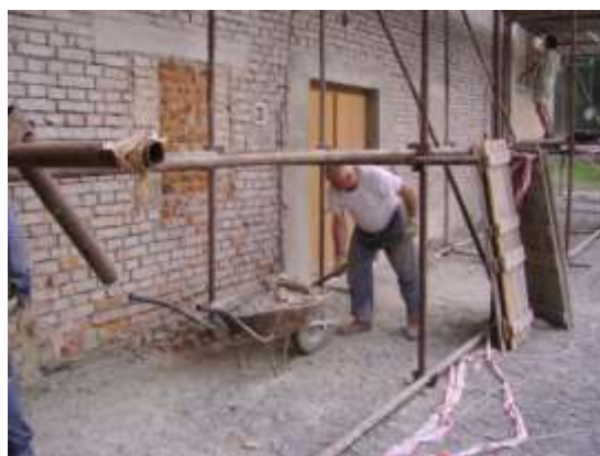
Obrázek 173 Otlučené fasády bylo mnoho, bylo nutné ji odvézt
