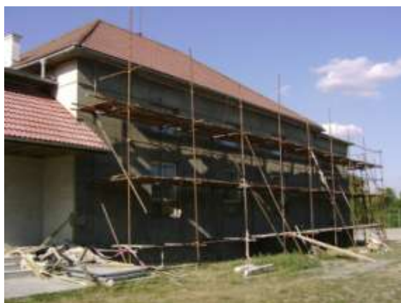
Obrázek 175 Lešení bylo postavené kolem jihozápadní stěny a od hřiště
