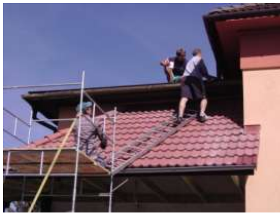
Obrázek 222 Z. Filak provedl nátěr celé sokolovny , na některé práce si pozval i své syny
