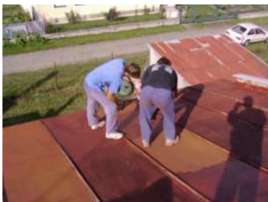
Obrázek 178 Nátěr střechy nad jevištěm
