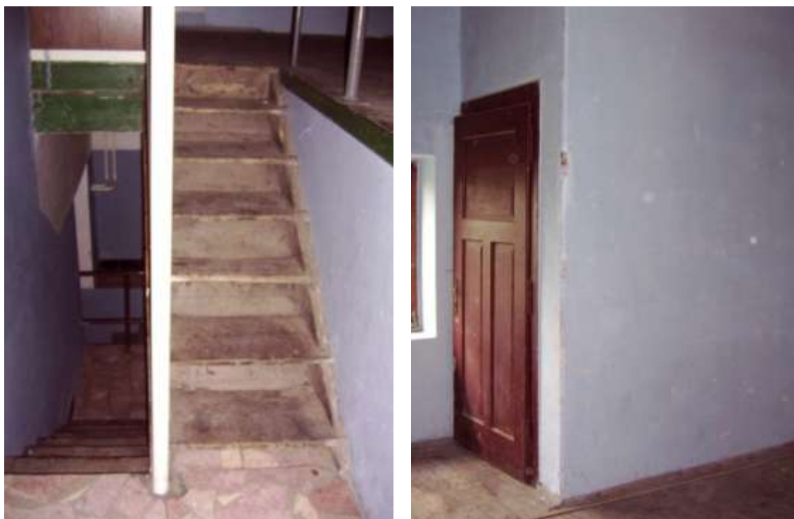
Obrázek 104 Původní schodiště na jevišti, Obrázek 105 Schody na půdu vlevo schody do bufetu
