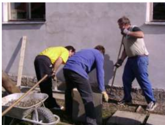
Obrázek 172 Otlučené fasády bylo mnoho, bylo nutné ji odvézt
