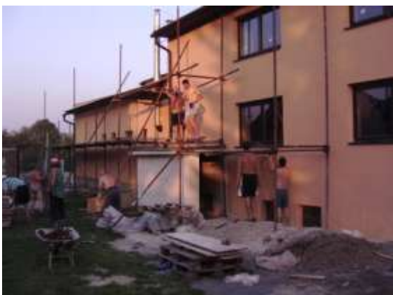
Obrázek 217 Na demontáž lešení bylo potřeba pomoc mnoha členů
