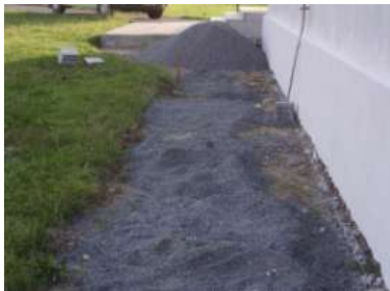
Obrázek 214 Po vydláždění za sokolovnou jsme udělal chodník podél sokolovny
