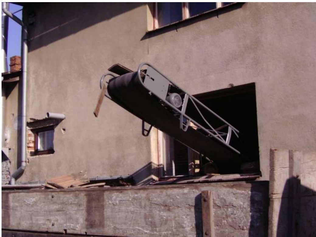
Obrázek 132 Parkety skončily na vlečce, záklop byl vyvezen na zahradu a spálen, dřevo bylo nakažené dřevomorkou
