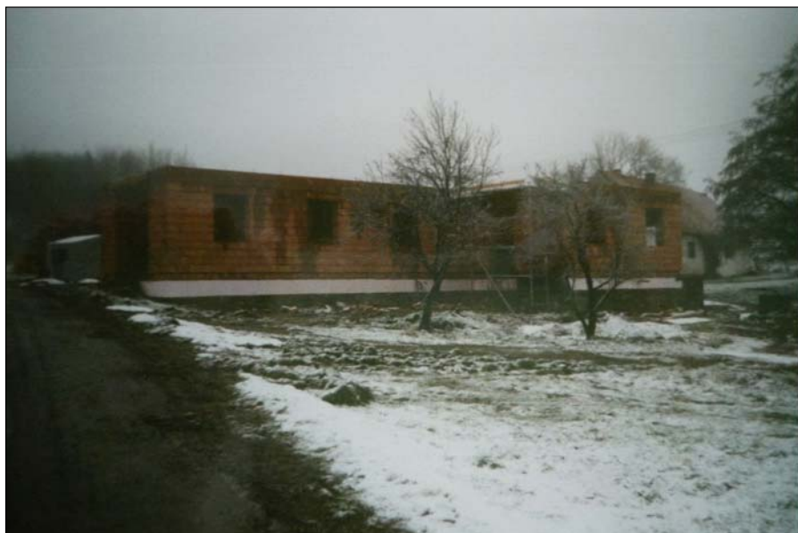
2007 – hrubá stavba budoucí hasičské zbrojnice.
