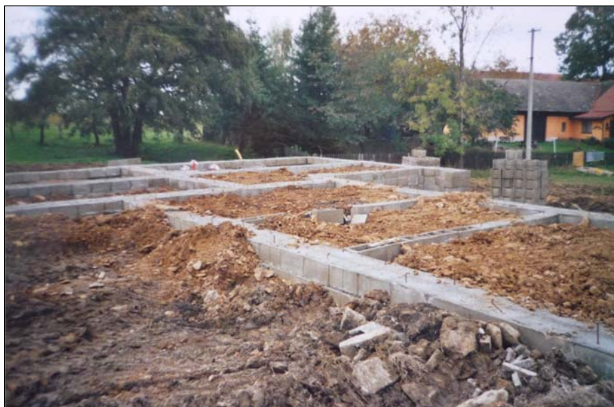
2007 – základy nové hasičské zbrojnice.
