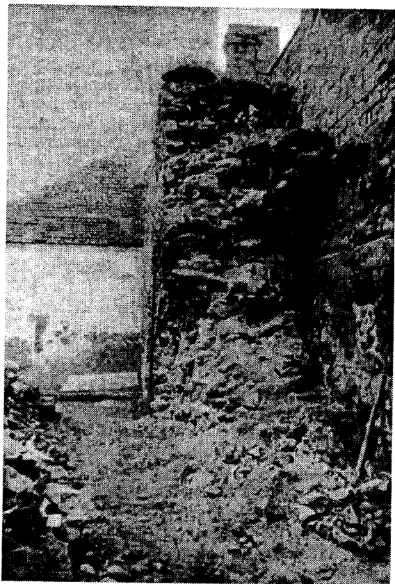
Obr. 9. Profil hradby za čp. 27.
