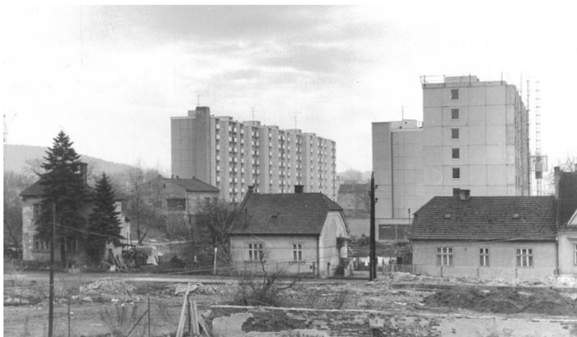
..● Ulice Patrice Lumumbý, v popředí zbořeniště jatek (čp. 569), 1981.
