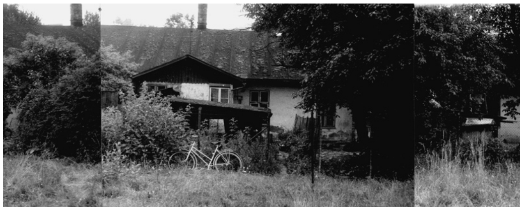
Pohled na obecní domky nedlouho před demolicí
