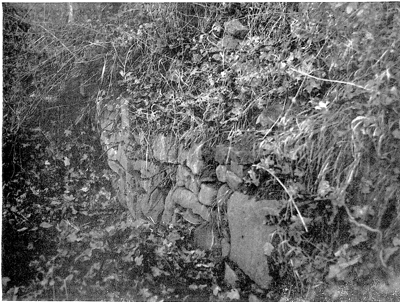
Hrad Luleč u Vyškova — pohled na zbytky hradního paláce. Foto autor.
