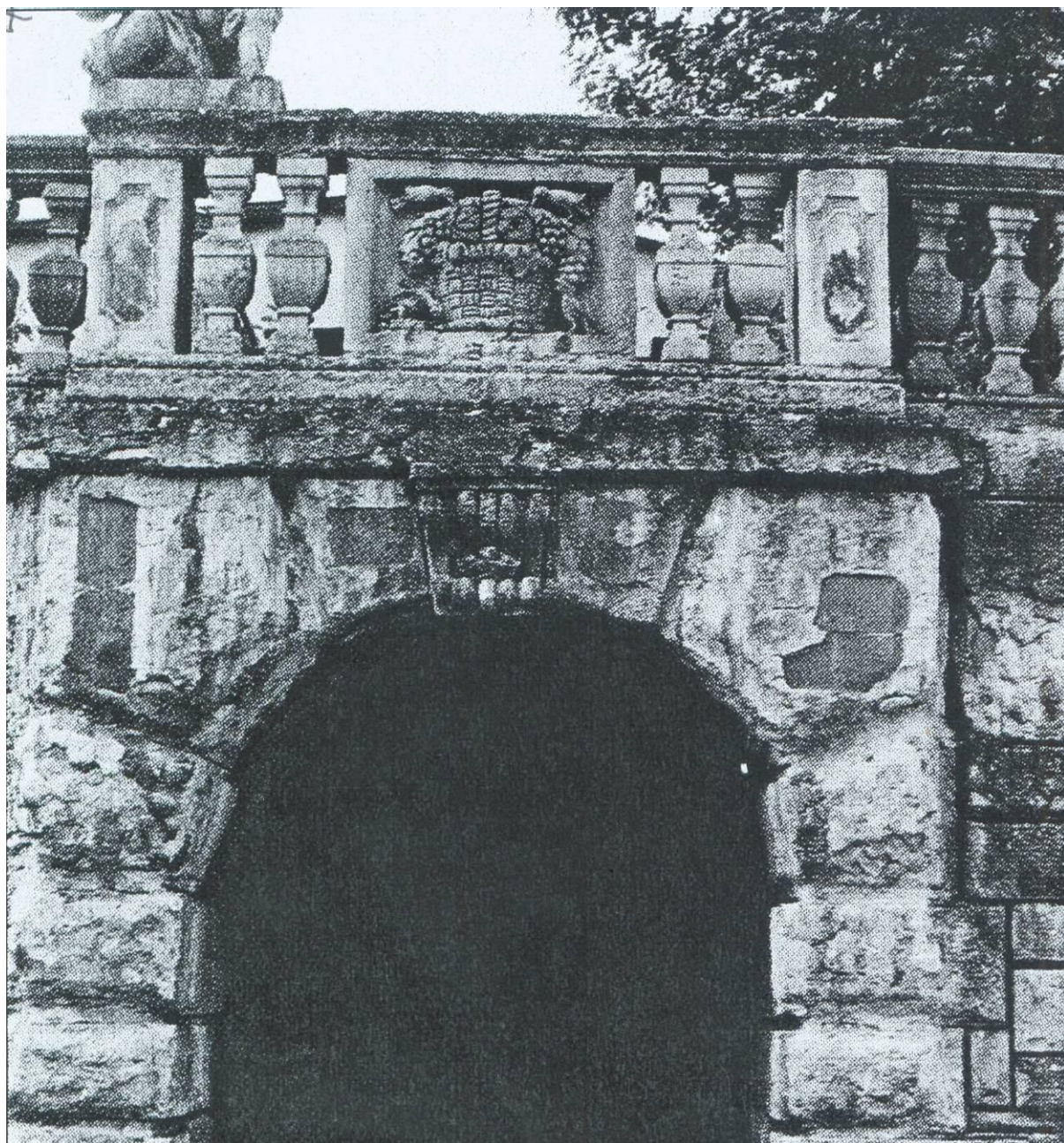
Vchod do štoly sv. Šebestiána, v 18.století název sv. Barbora Portál vyzdobený Ed. Schopenhauerem ( foto archiv autora )
