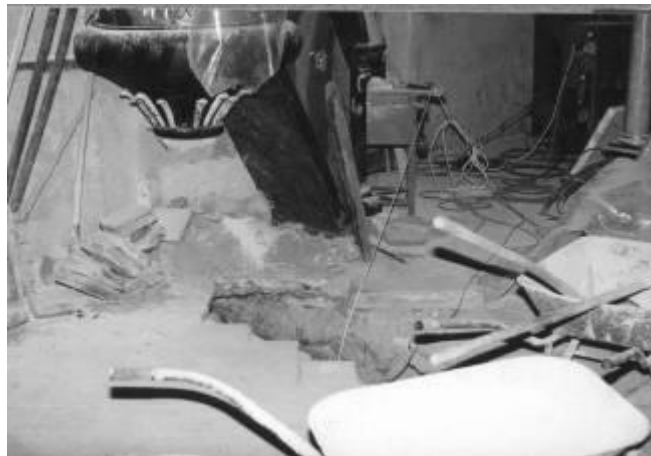
Stav interiéru při nálezu vchodu do krypty
